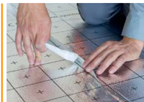
Solapa autoadhesiva con cinta protectora.
