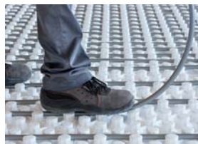
Sencilla y cómoda colocación del tubo.
