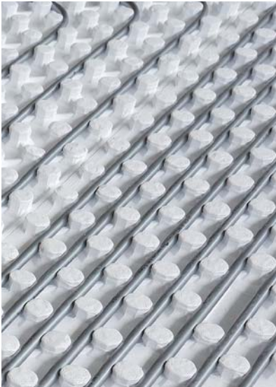
Instalación de suelo radiante con Sistema NP en Guardería de Valtierra (Navarra).
