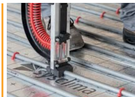
Cómoda colocación del tubo con grapa 3D.
